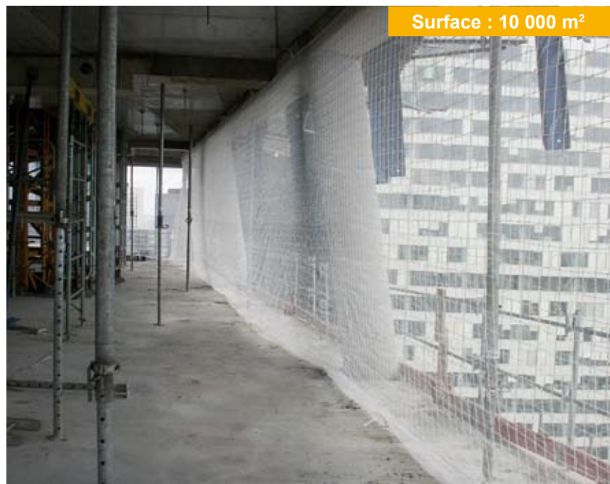
Fourniture, pose et dépose de filet de sécurité anti-chute d'homme doublé pare-gravats en façade.
