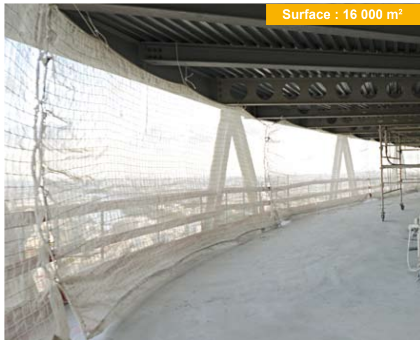
Fourniture, pose et dépose de filet de sécurité anti-chute d'homme doublé pare-gravats en façade.
