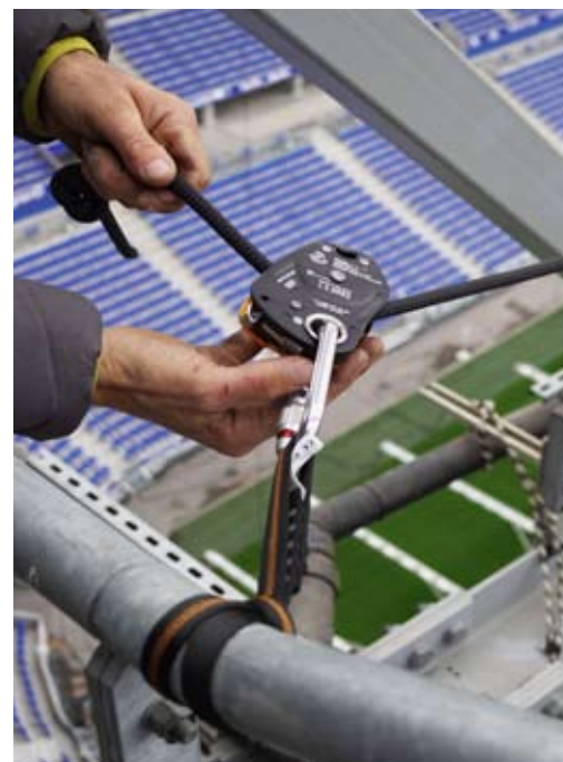
Fourniture et pose d'un filet anti-projectiles
