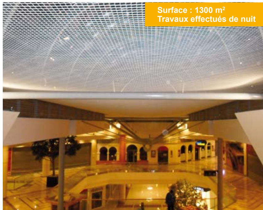
Fourniture et pose de film de protection et filet en sous-face des verrières du Centre commercial régional.
