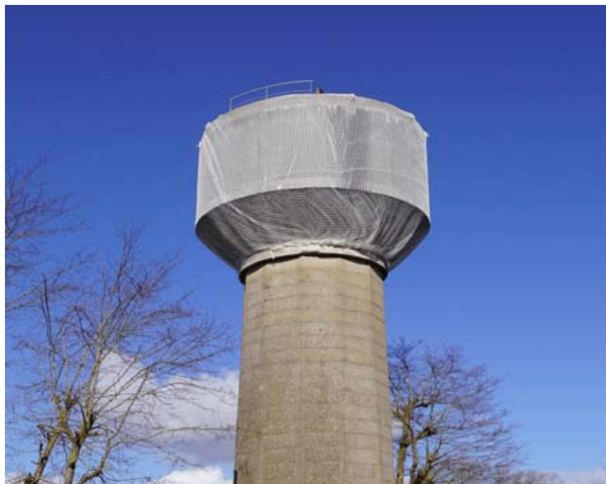
Fourniture d'un filet de protection anti-gravats
